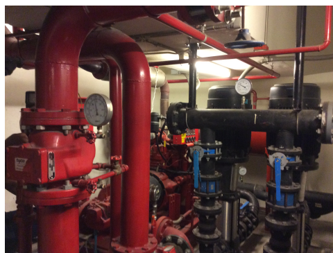
ภาพที่ 1-15 เครื่องสูบน้ำดับเพลิง
