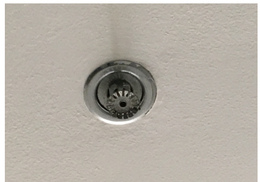
ภาพที่ 1-14 ระบบโปรยน้ำดับเพลิง
